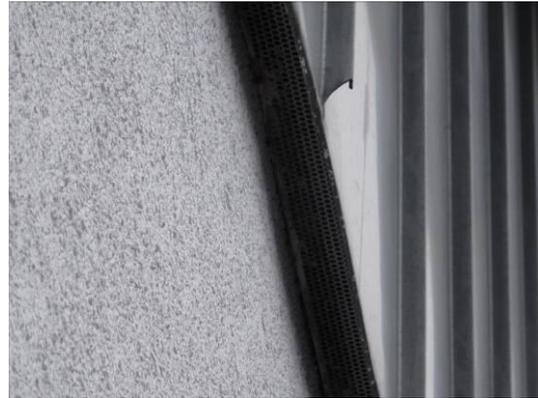
Abb. 8 Spalten hinter der Verkleidung an der Ostseite.
