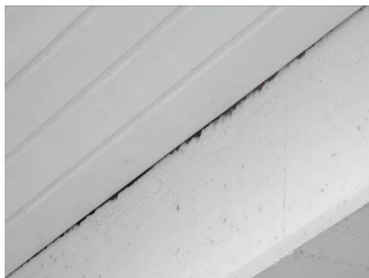
**Abb. 29** Spalte in der Vertäfelung über der Anlieferung.
