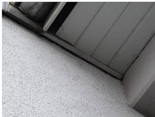
**Abb. 27** Spalten und Öffnungen im Bereich der Anlieferung.
