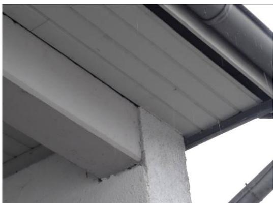
**Abb. 28** Spalte in der Vertäfelung über der Anlieferung.
