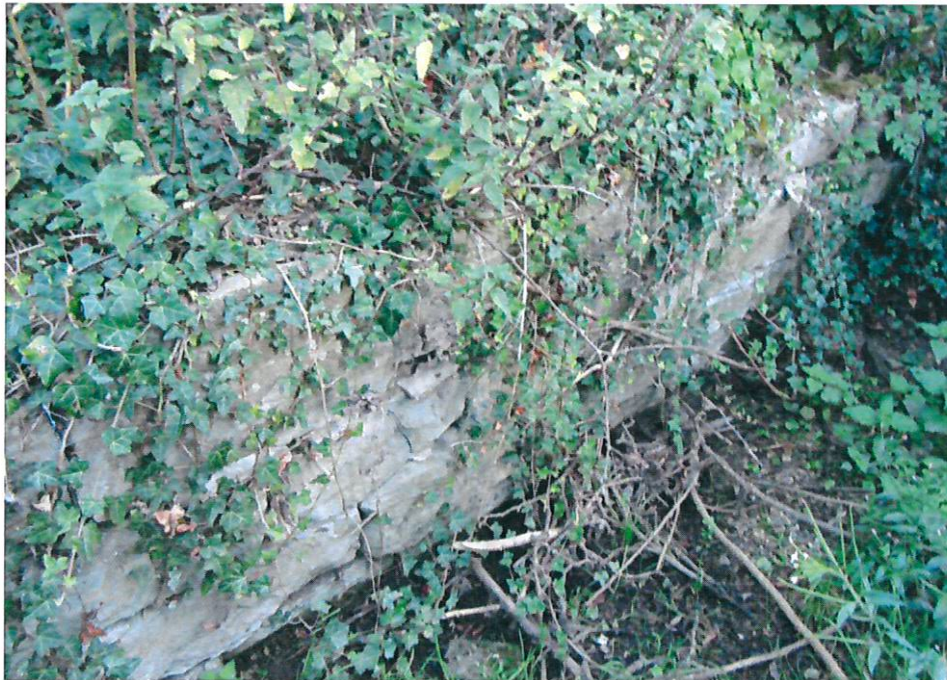
Abb. 13 Gemauerte Befestigung der Uferbereiche.
