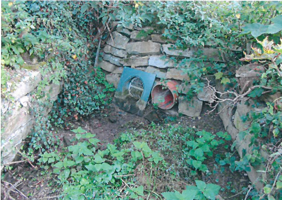
Abb. 12 Auslaufbereich der Verrohrung westlich des Gebäudes „Torhaus“.
