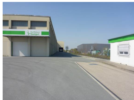
Abb. 7 Blick auf die westlich angrenzende Lagerhalle der Firma Raiffeisen.
