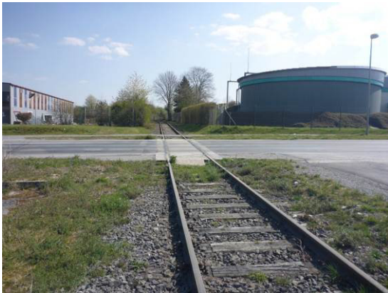
Abb. 14 Bahnschienen an der nördlichen Plan- gebietsgrenze. Blick Richtung Osten.
