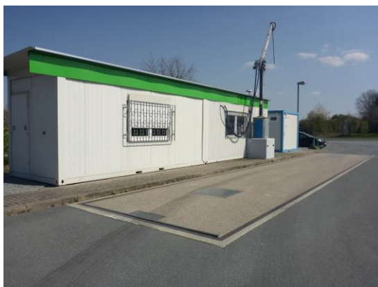
Abb. 6 Bürocontainer im nördlichen Plangebietsbereich.
