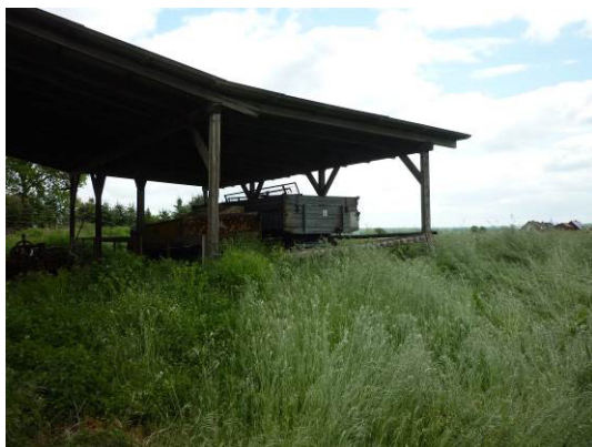
Abb. 5 Remise im Plangebiet.
