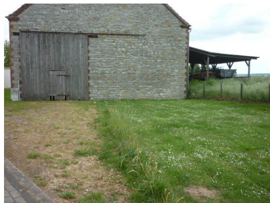
Abb. 6 Angrenzend an Remise liegende Scheune.
