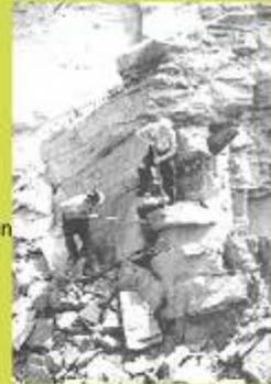
Die Steine wurden von Hand mit Vorschlaghammer, Meißel und Brechstange gebrochen und mit Pferdefuhrwerken oder Karren abtransportiert. Teilweise abgebrochene Kalkbänke sind auch heute im Steinbruch noch deutlich zu erkennen.
